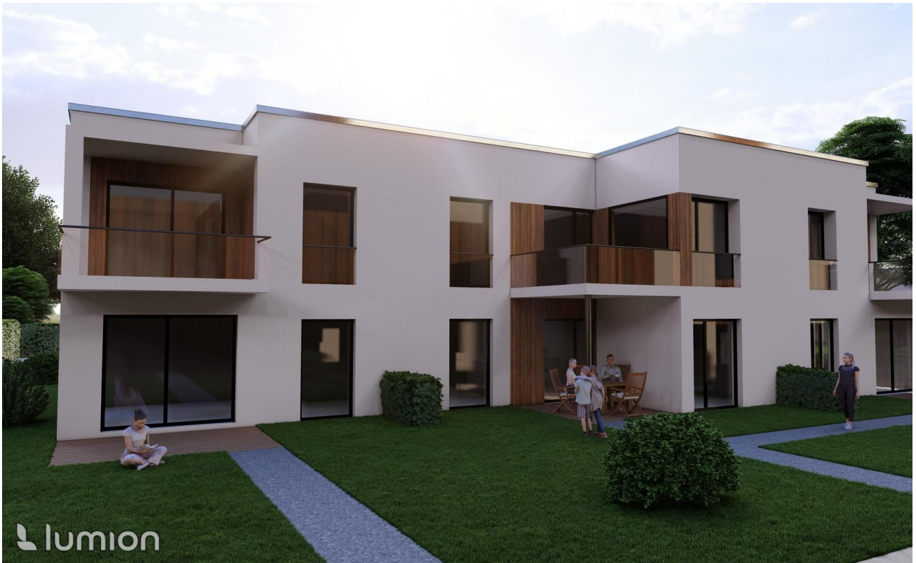
MFH Ansicht Südwest
