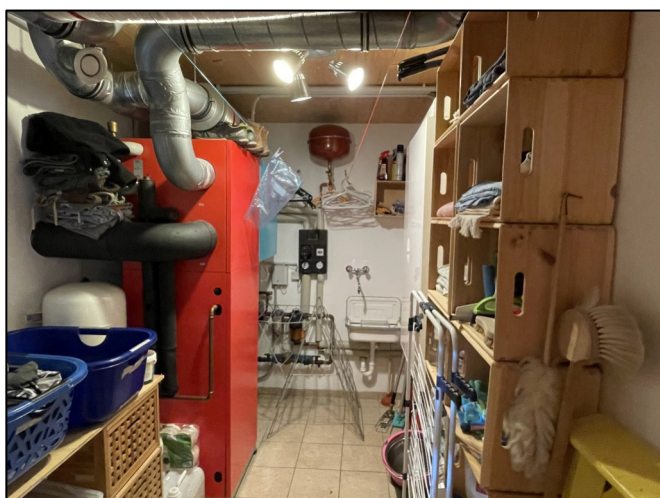
Wasch- und Heizraum EG.
