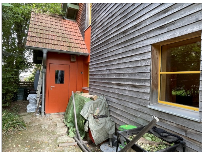
Ansicht Ost mit Geräteschuppen.
