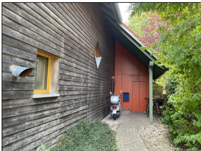
Ansicht Nord mit Geräteschuppen.
