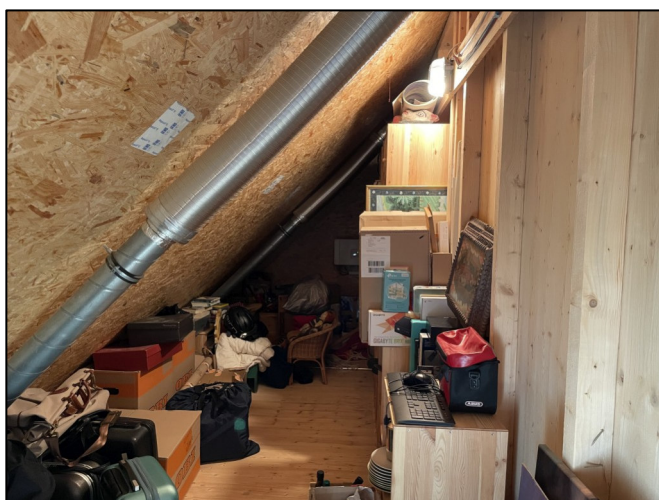
Dachgeschoss, nicht ausgebauter Teil.
