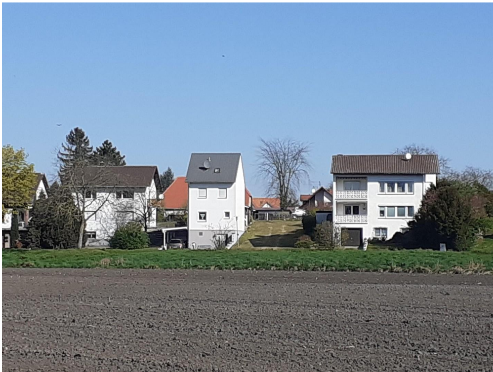
Außenansicht DH-Hälfte vomFeld
