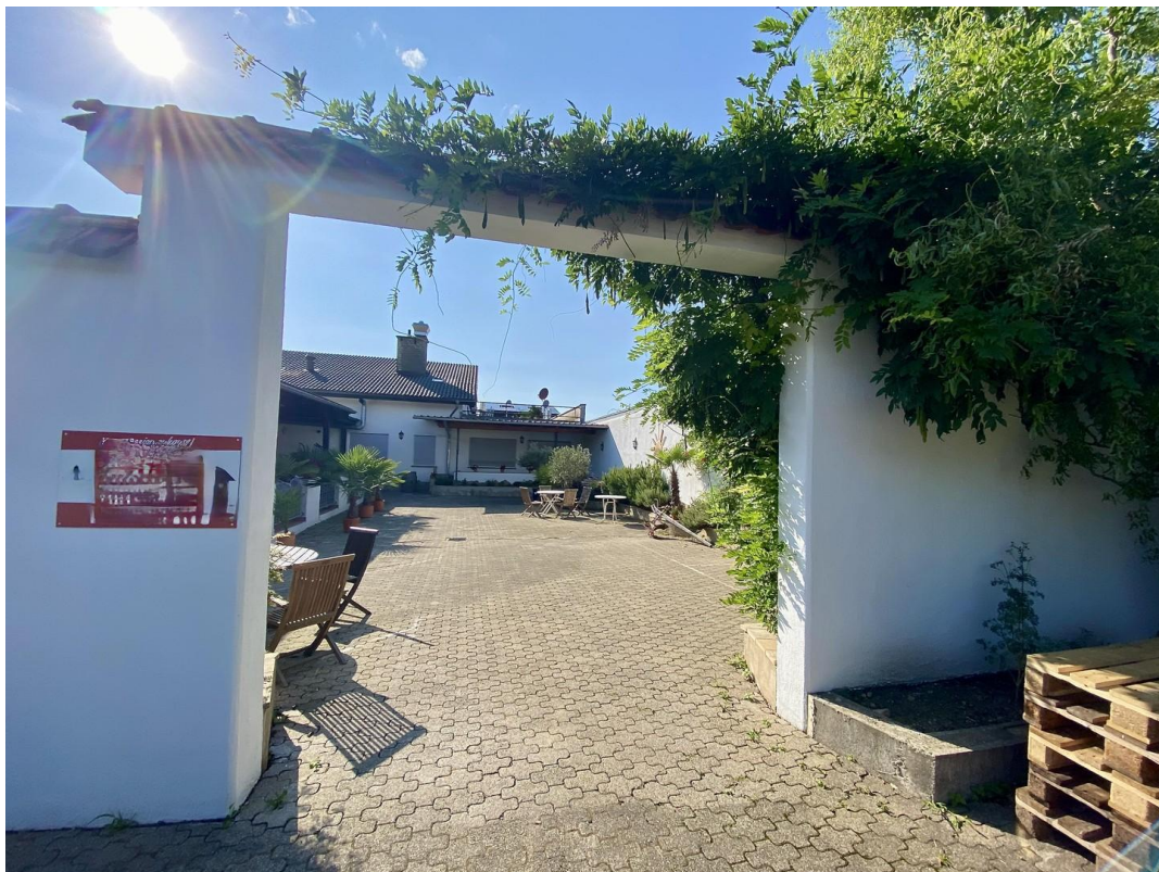
Eingang Innenhof v. Parkplatz
