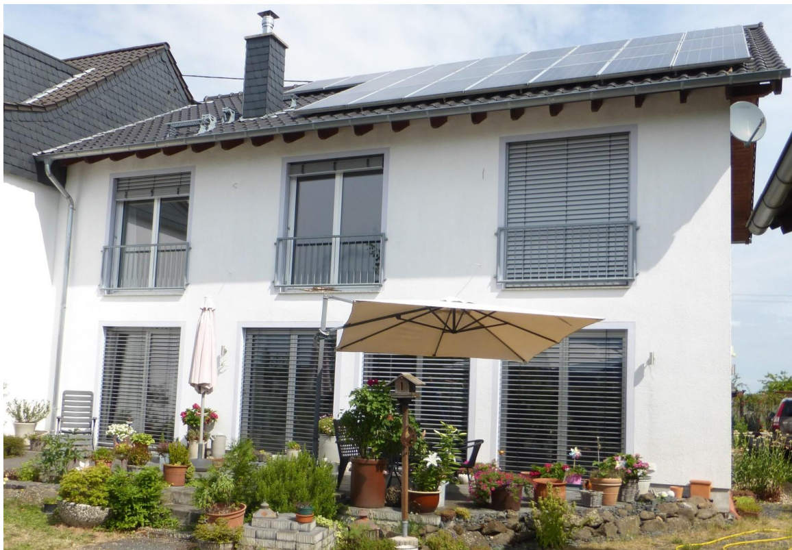
Südansicht mit PV-Anlage
