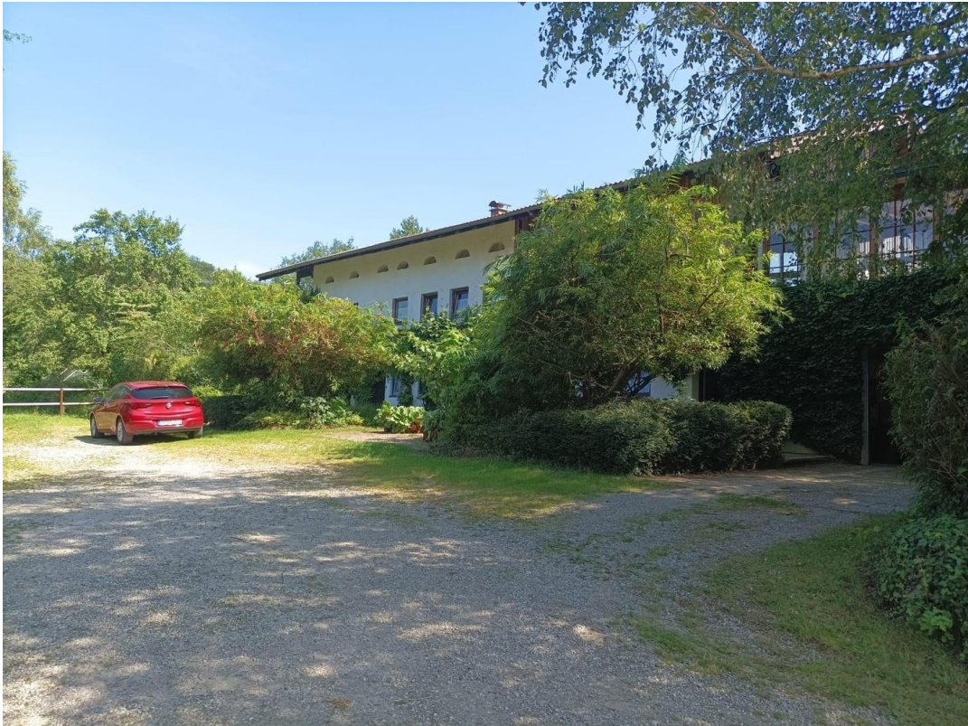
Ansicht Nordseite mit Hof
