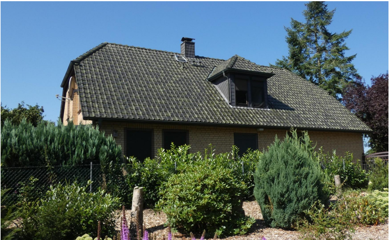
Dachfläche mit Gaube
