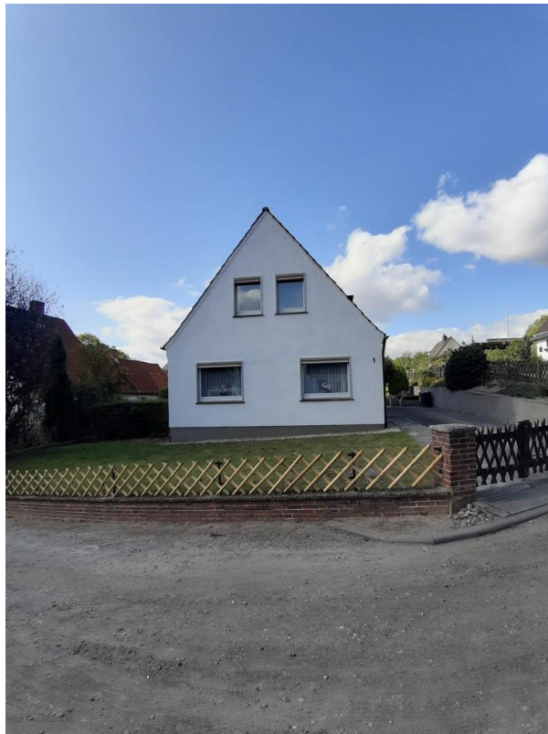
Ansicht von der Strasse
