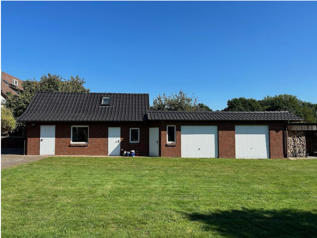
Garagen und Nebengebäude
