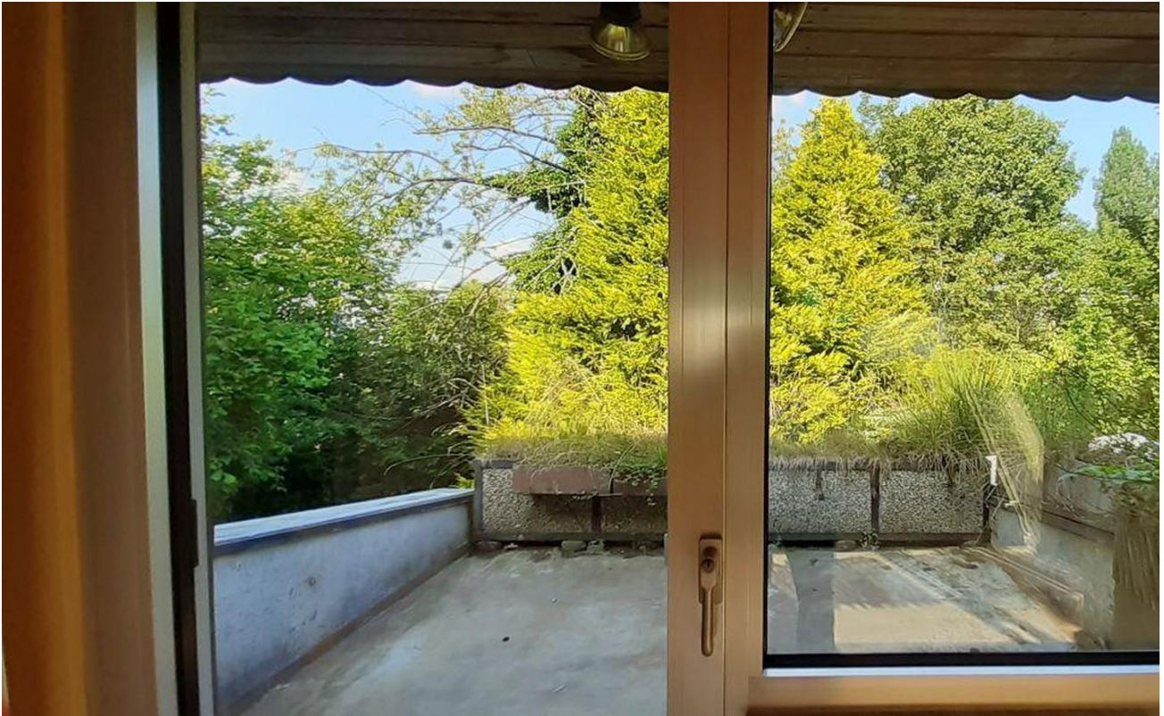
Zimmer 1 DG - Dachterrasse
