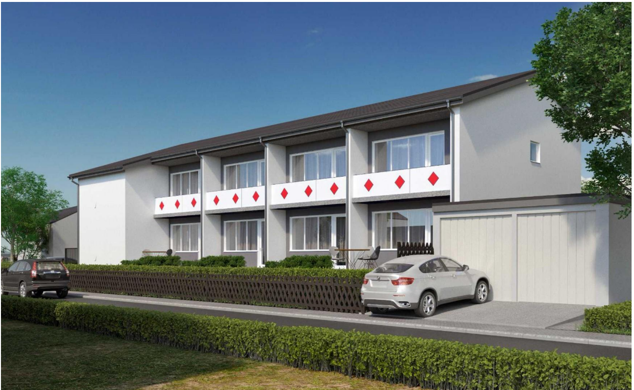
Strassenseite mit 2 Garagen
