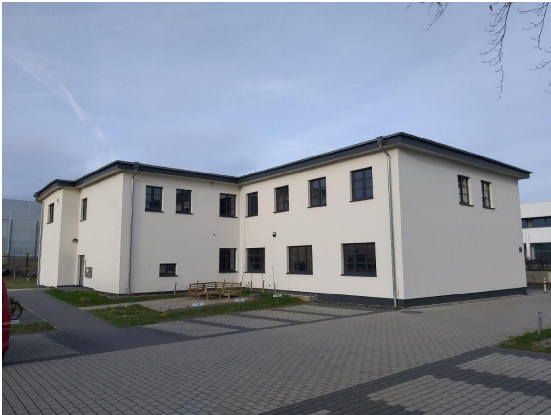
Gebäudeansicht mit Parkplätzen
