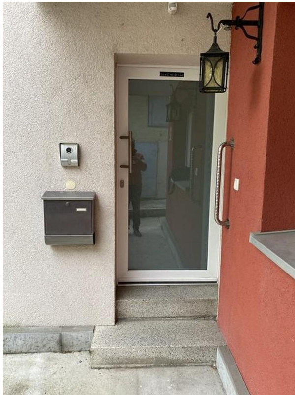
Haustüre mit Videosprechanlage
