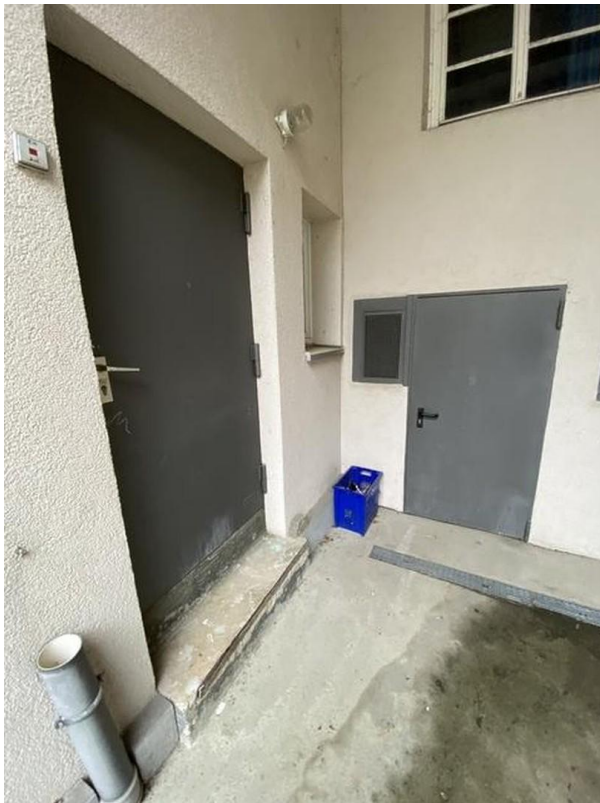
Zugang Heizraum, Abstellräume
