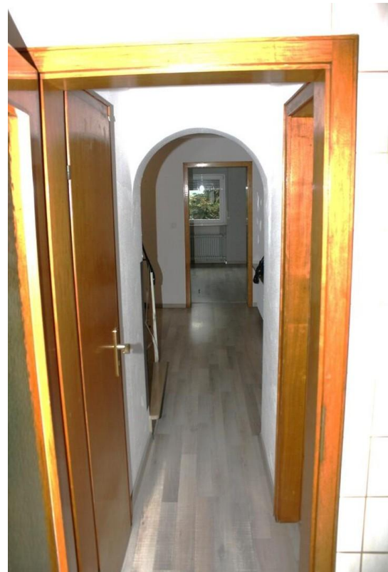
Flur im OG1
