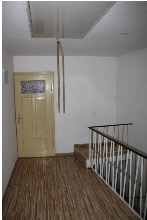
Flur OG2 Zugang Abstell- und HW-Raum
