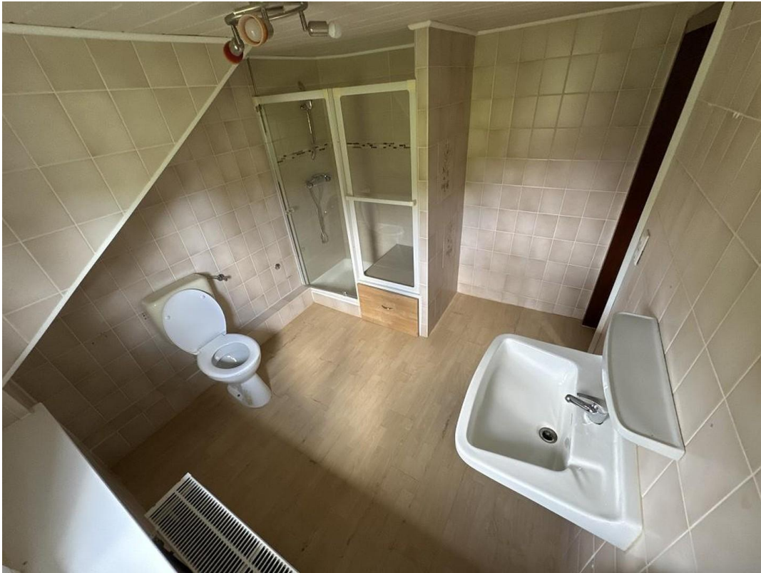
Nebenhaus Bad 1.OG
