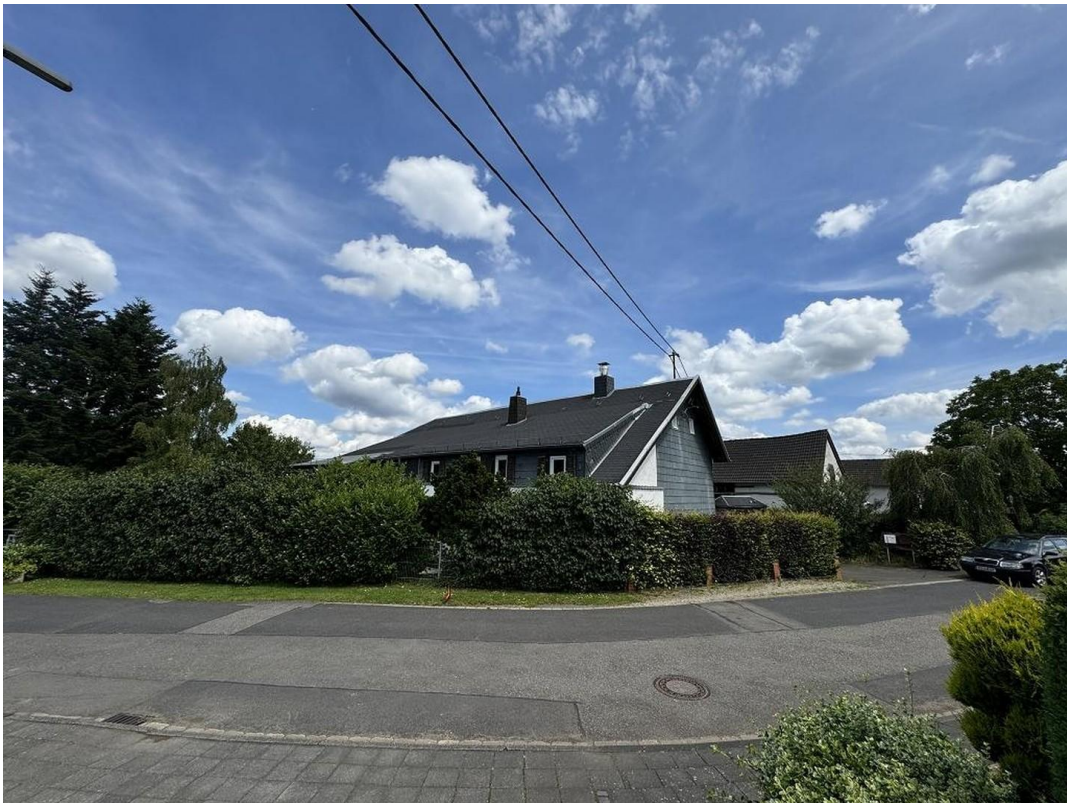
Ansicht andere Straßenseite
