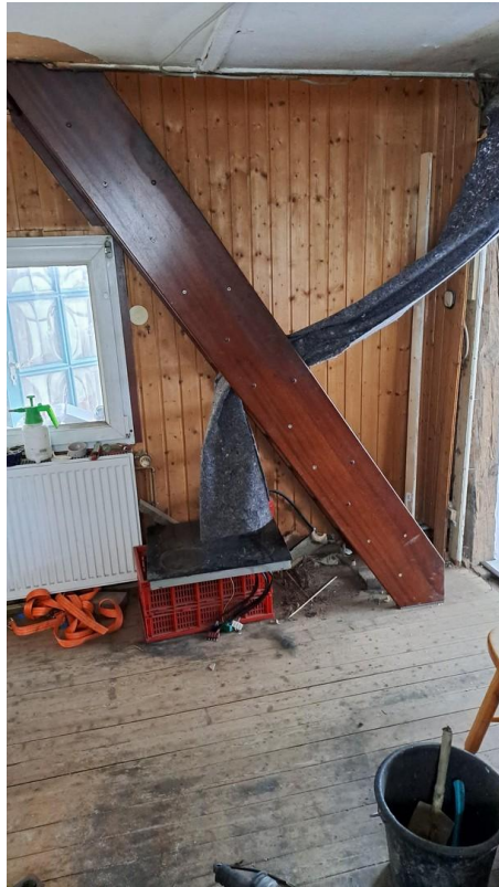
Treppe ins OG
