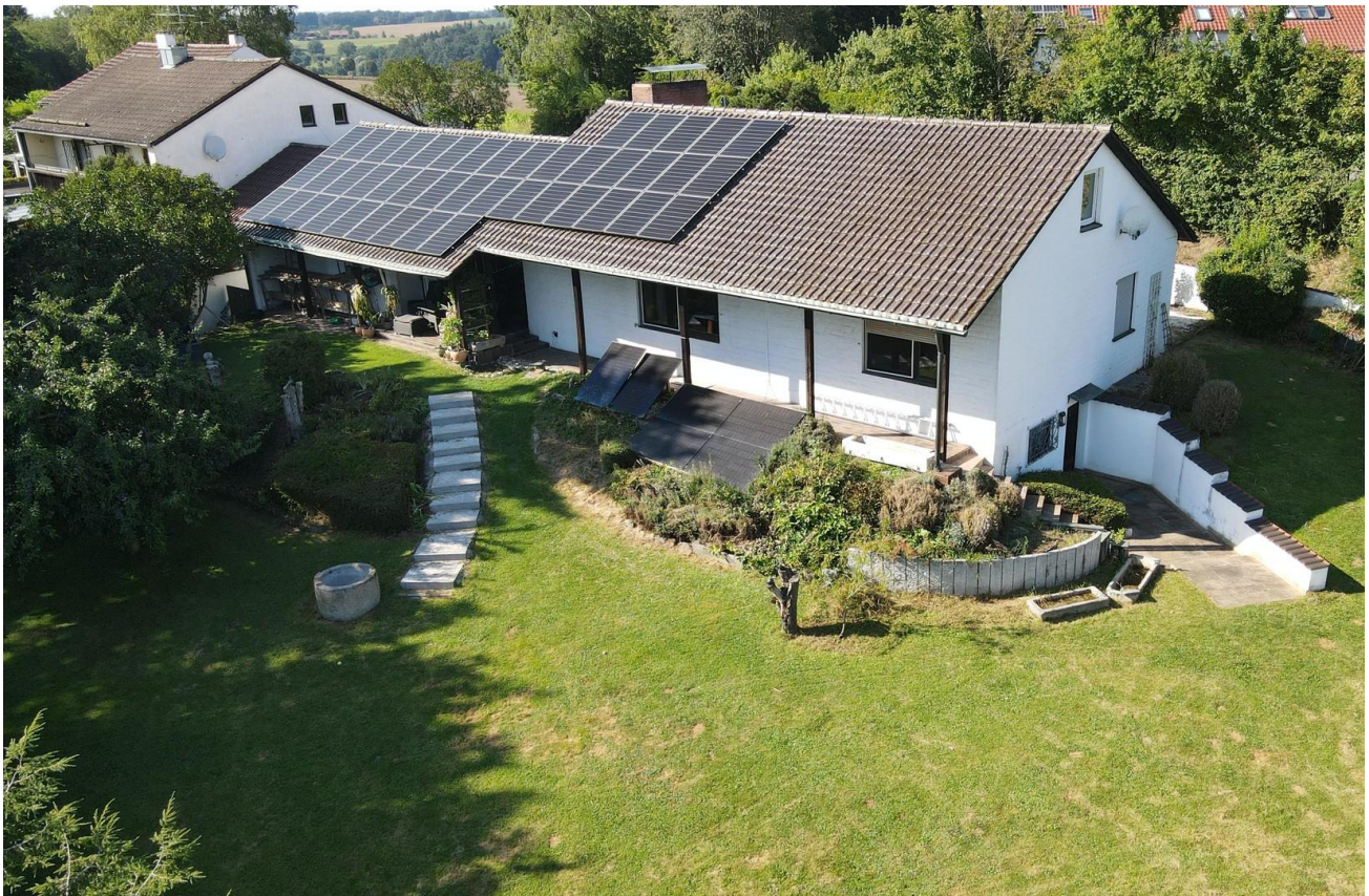
Sicht von der Südseite
