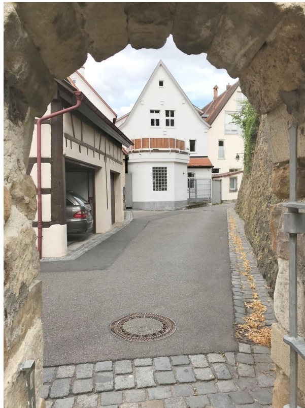
Rückseite mit Dachterrasse
