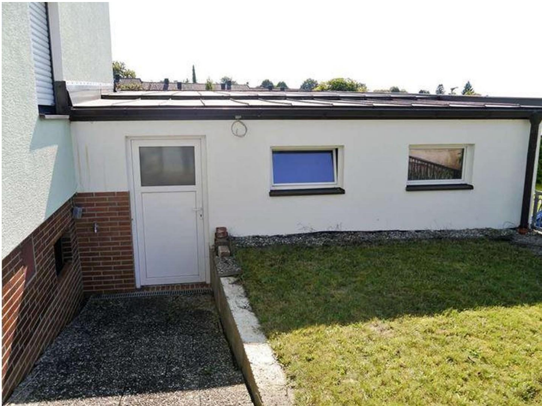
Werkstatt Zugang vom Garten
