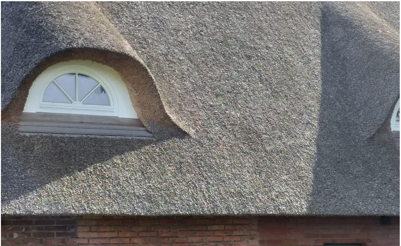
DG mit Gauben ausbaufähig
