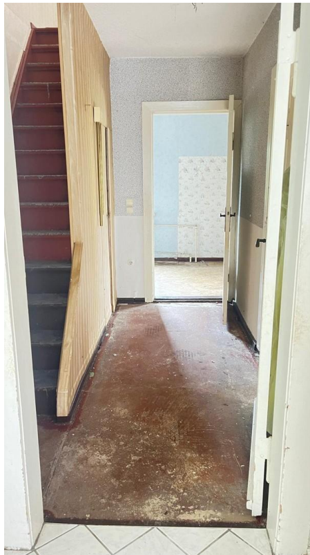
Flur mit Treppe OG
