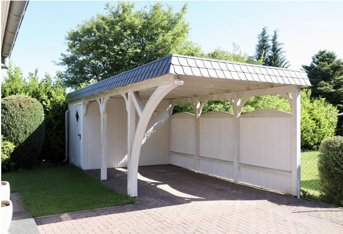
Carport mit Abstellraum
