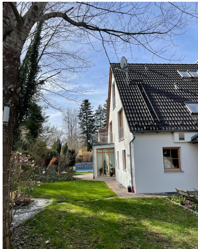
Haus östliche Ansicht
