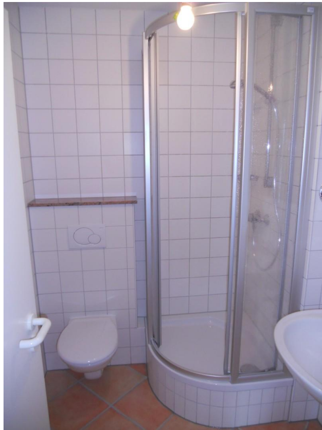
Duschbad mit WC
