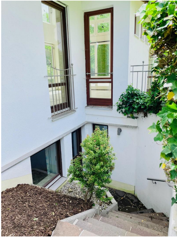
Abgang zum Einliegerbereich
