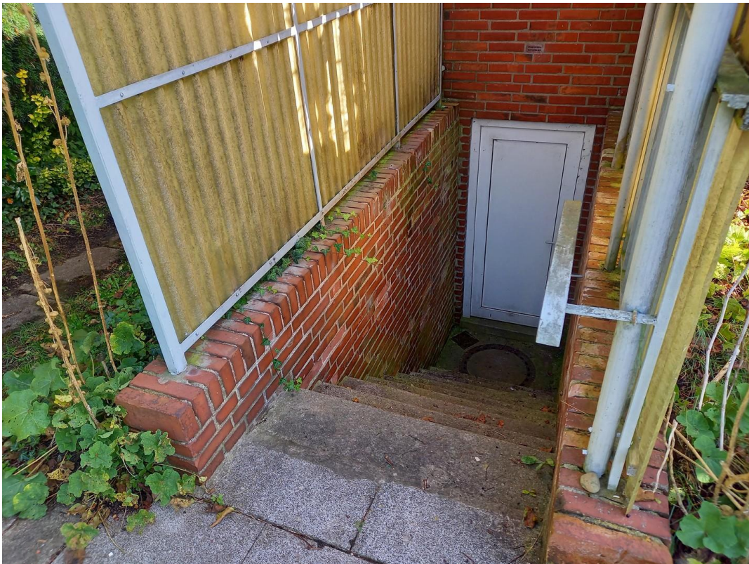
Kellereingang vom Garten
