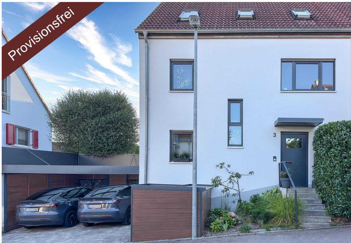
Hausansicht von der Straße
