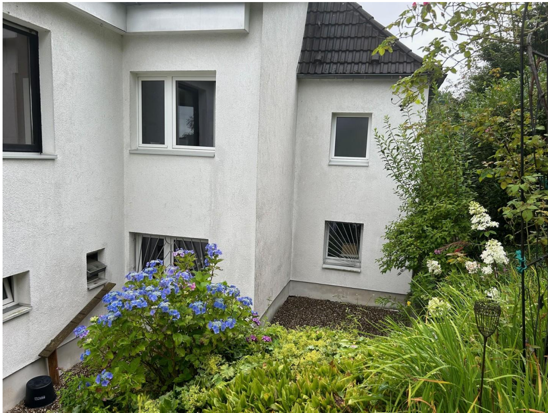
Blick in den Hof (Nordseite)
