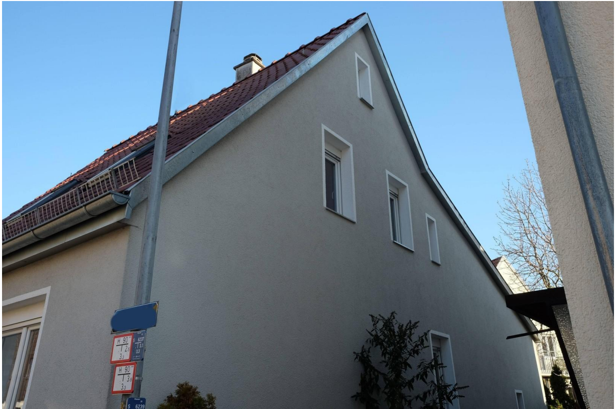
Haus von der Straße
