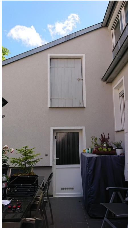
Terrasse/Anbau Zugang Außenbad
