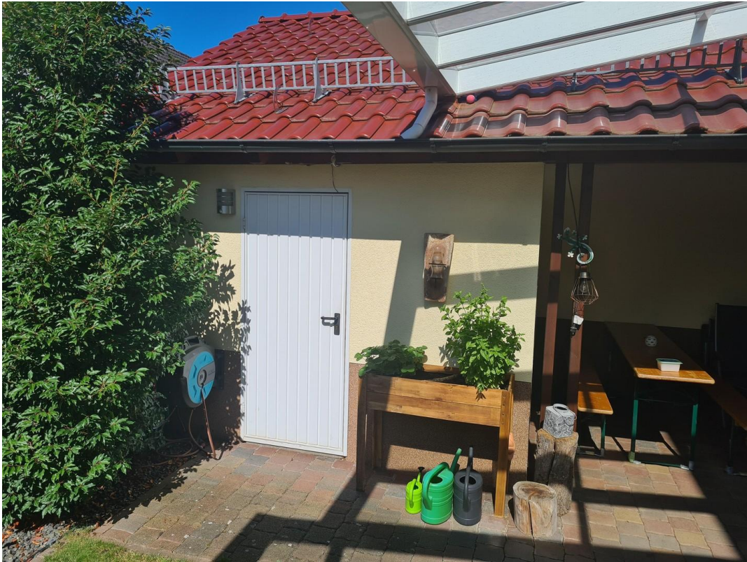
Carport mit Abstellraum
