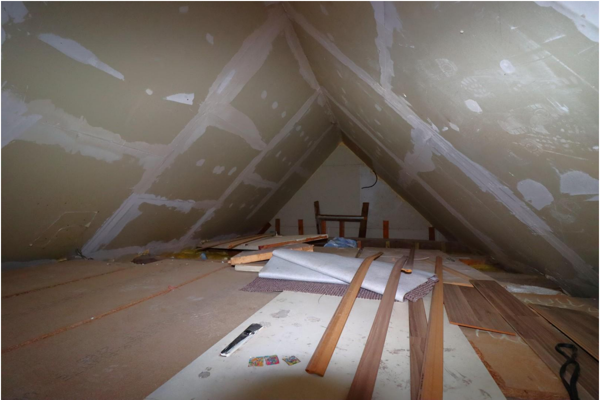
Dachboden Haus B
