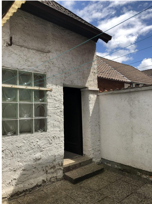
Zwischenhof zum Hinterhaus
