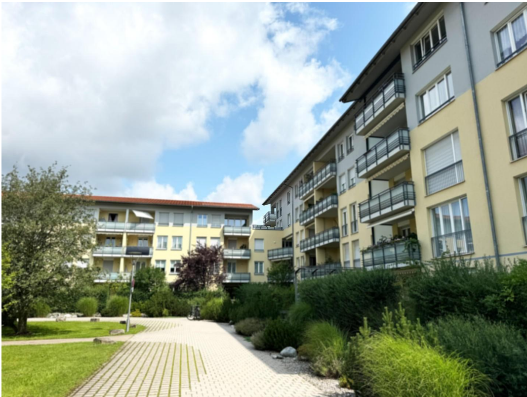
Blick von Innenhof mit Filter
