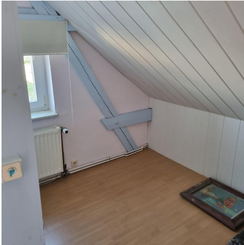
Kinderzimmer 1 DG II
