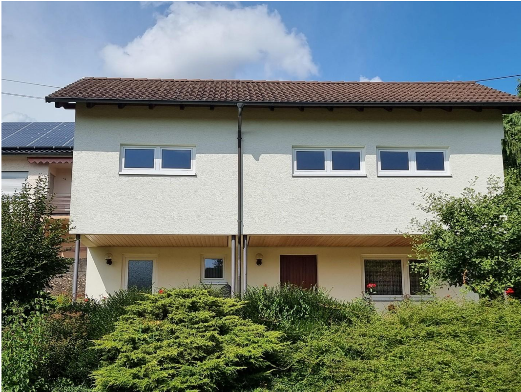
Garagen von Südseite
