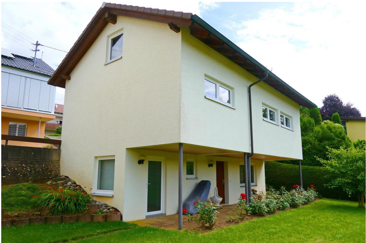
Garage von Südwestseite
