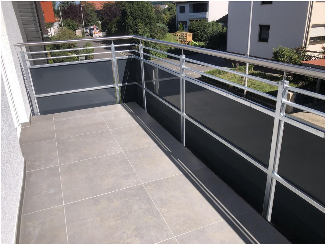
Ostbalkon (Zugang über SZ)
