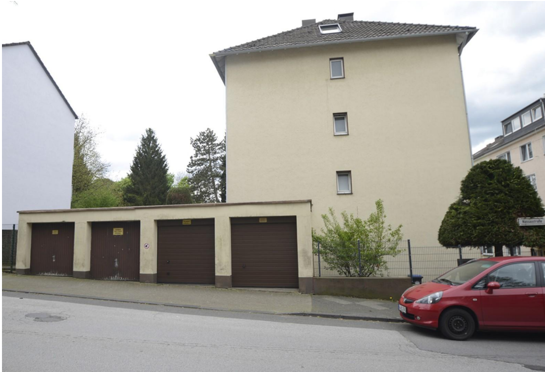
Seitenansicht mit Garagen
