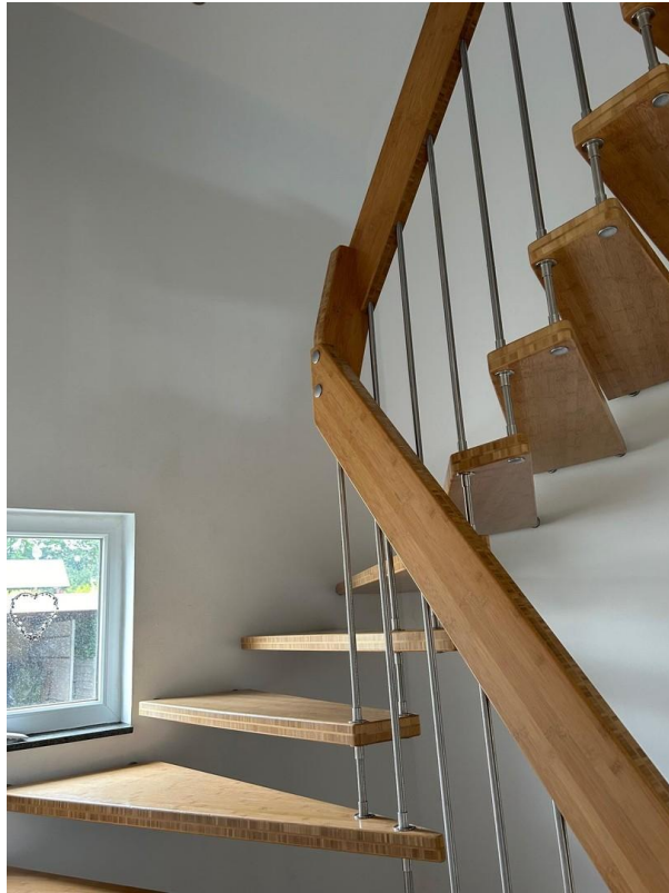
Bambustreppe zum OG
