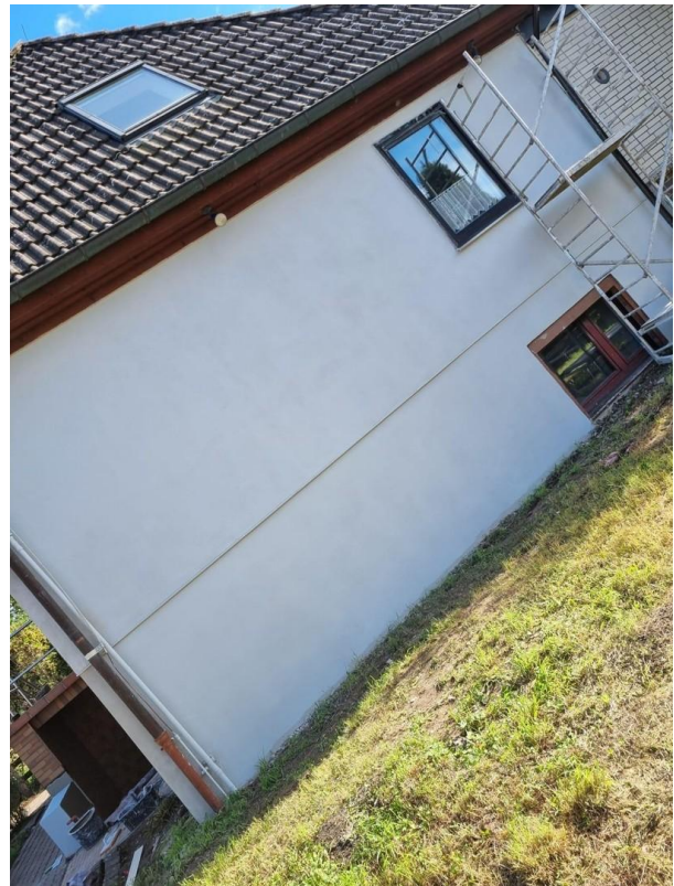
Fassade neu verputzt
