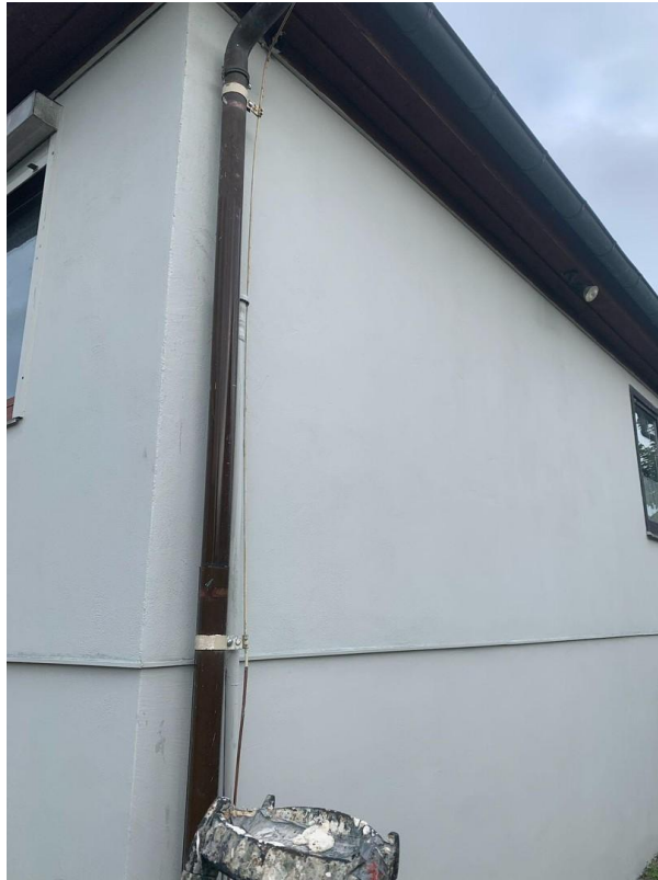
Fassade neu verputzt
