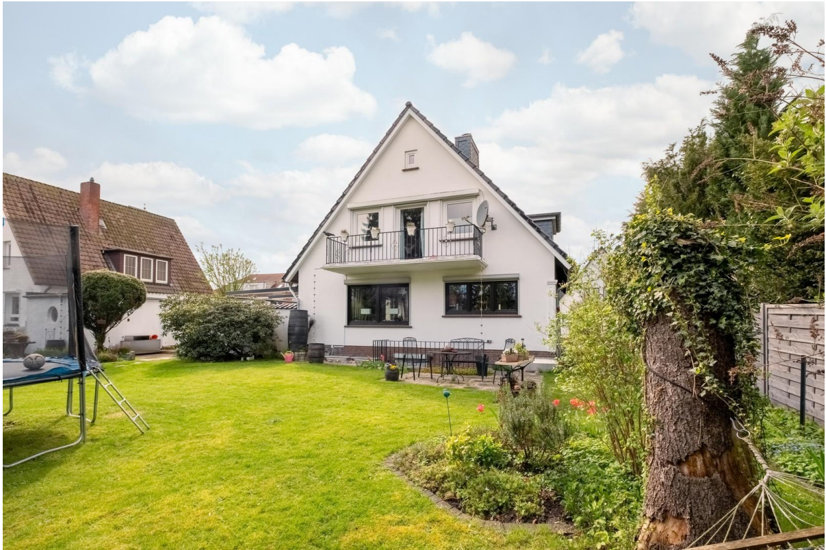
Haus Ansicht hinten vom Garten
