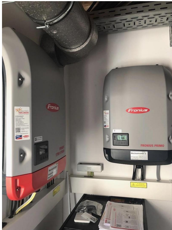
PV-Wechselrichter
