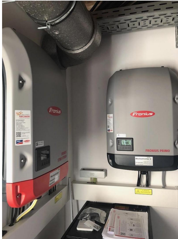
PV-Wechselrichter
