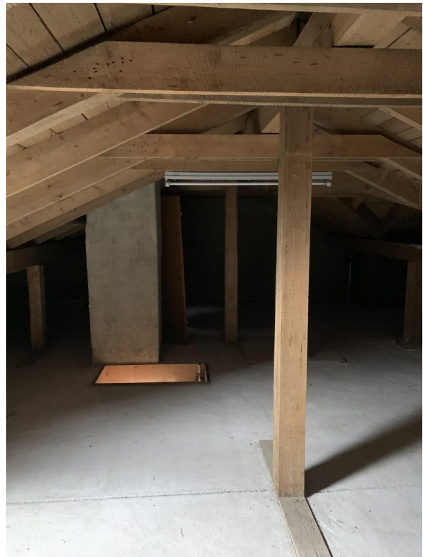
Dachstuhl mit Stehhöhe
