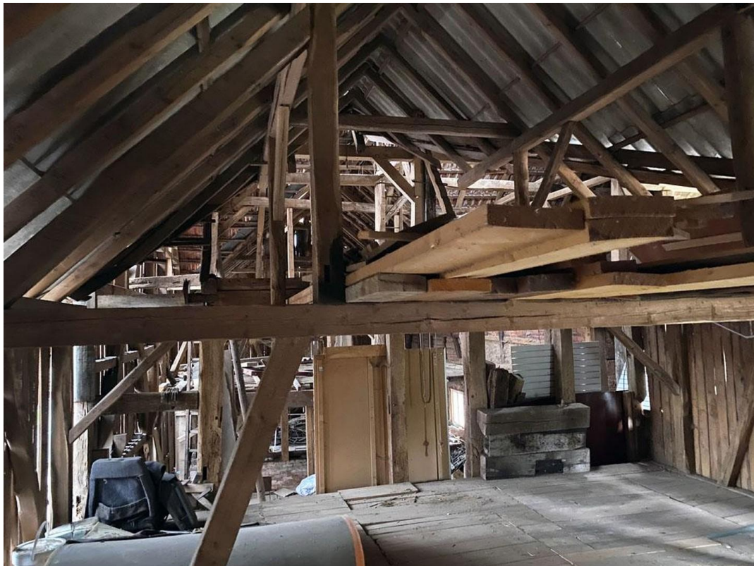
Dachböden Stallungen, Scheune
