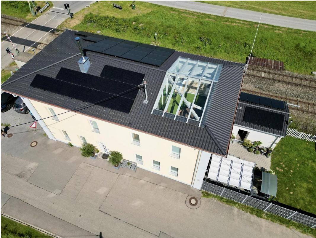
Luftbild von Südwesten
