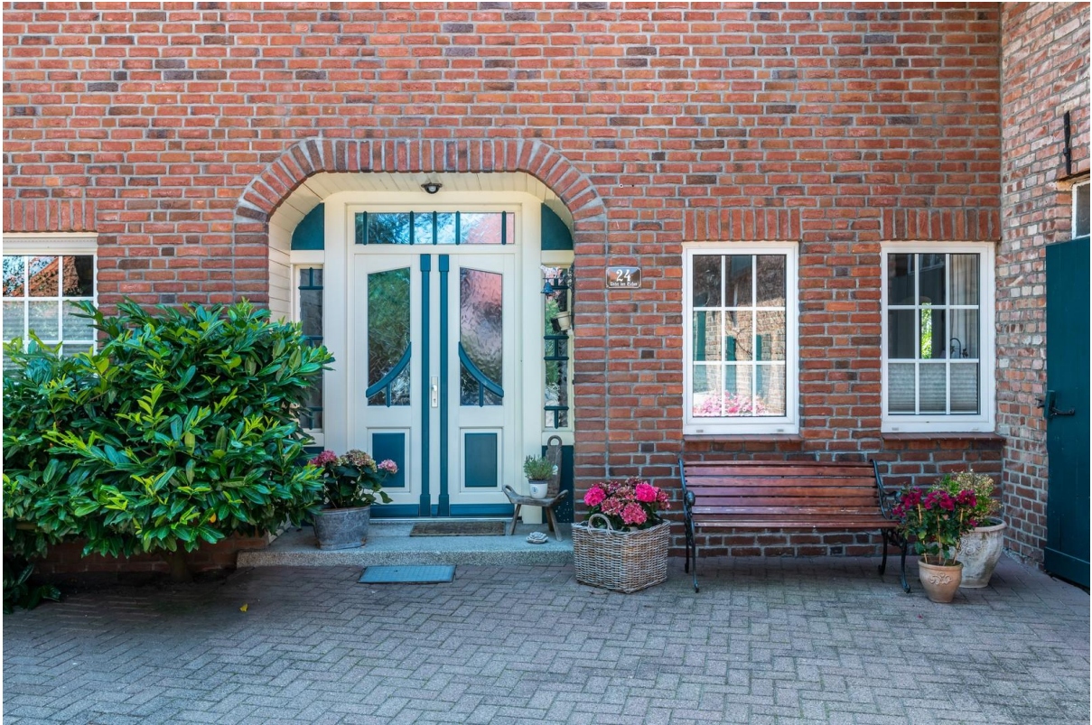
Eingang Wohnhaus rechts
