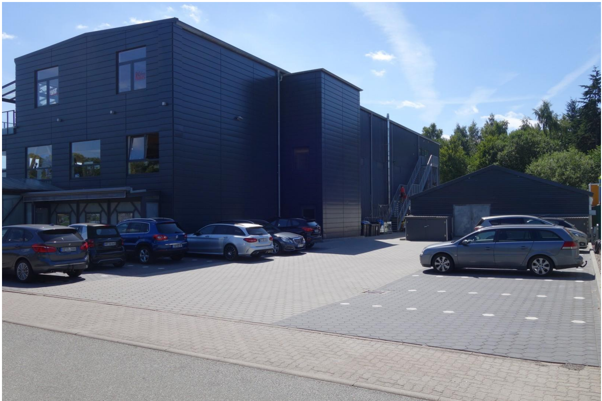
Rückseite und Parkplatz
