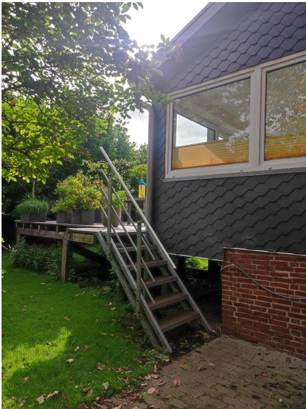
Treppe zur Terasse
