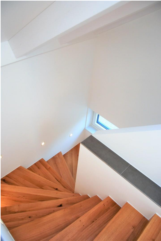
Massivtreppe mit Vollholz
