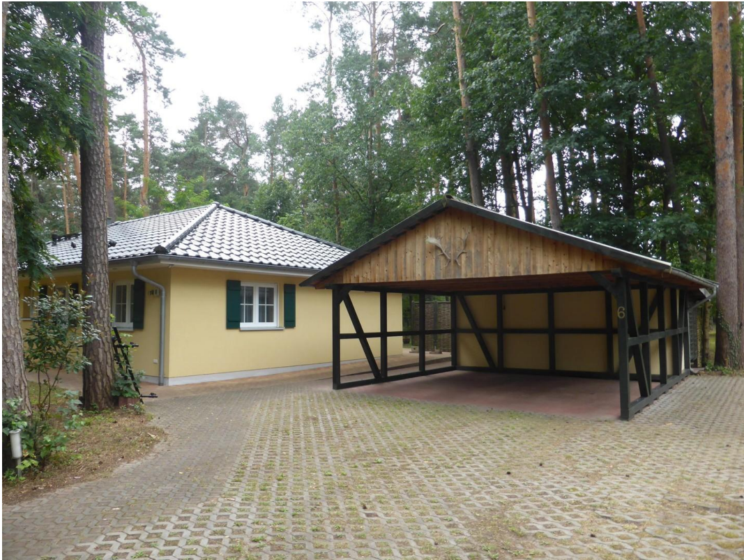
Carport mit 2 Stellplätzen
