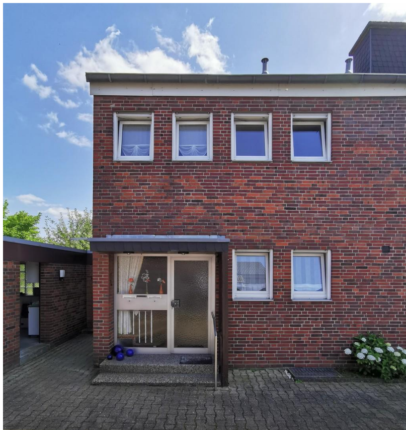
Ansicht von Norden, Eingang
