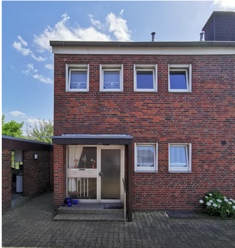
Ansicht von Norden, Eingang
