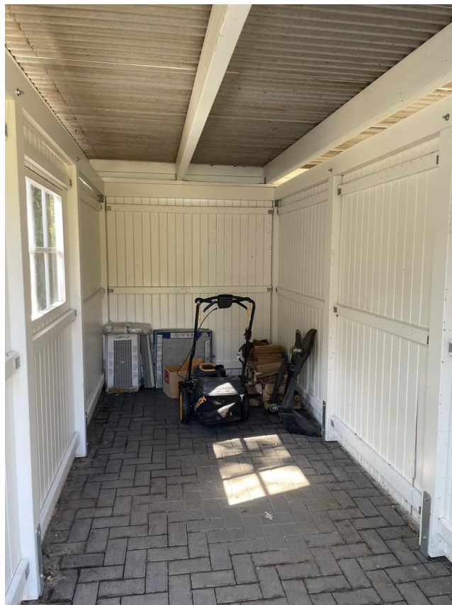
Schuppen am Carport
