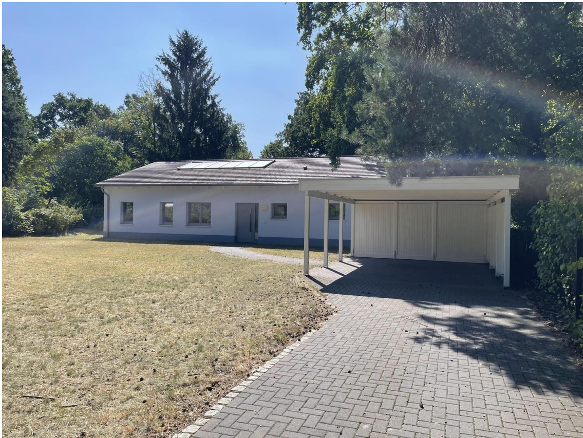
Haus mit Carport
