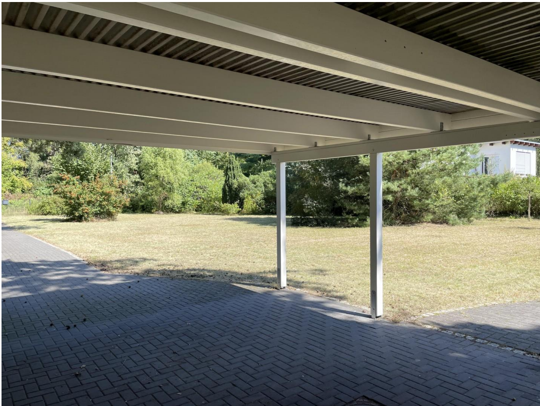
Blick aus dem Carport
