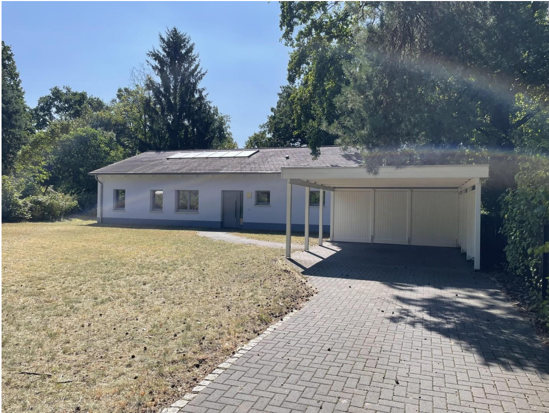
Haus mit Carport
