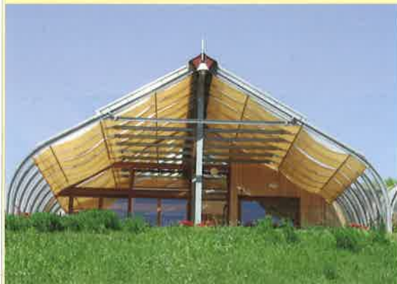
Bürogebäude im Sonnenpark St. Alban
