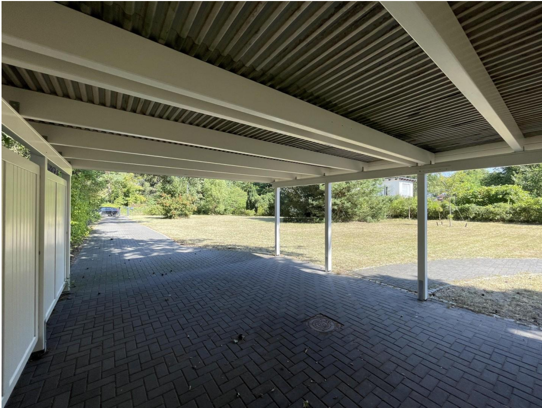
Blick aus dem Carport
